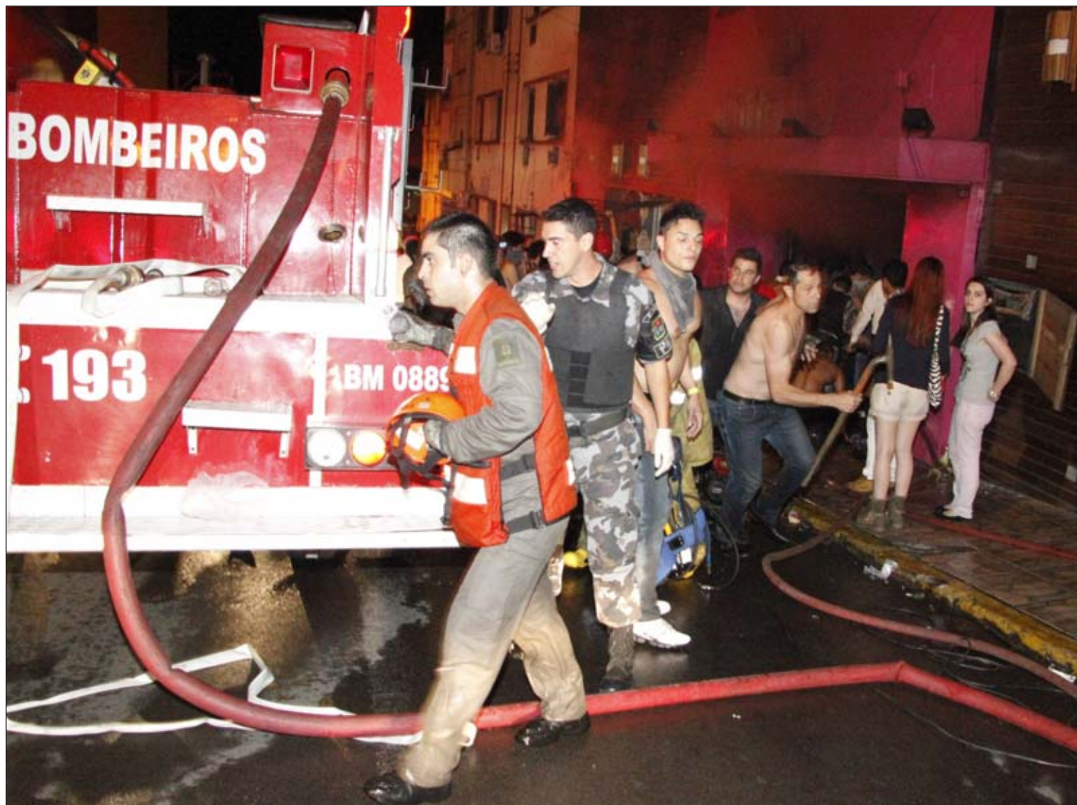
Bomberos y equipos de emergencia trabajaron ayer a destajo en la estructura del local y en las labores de rescate de cuerpos bajo los escombros. EFE
