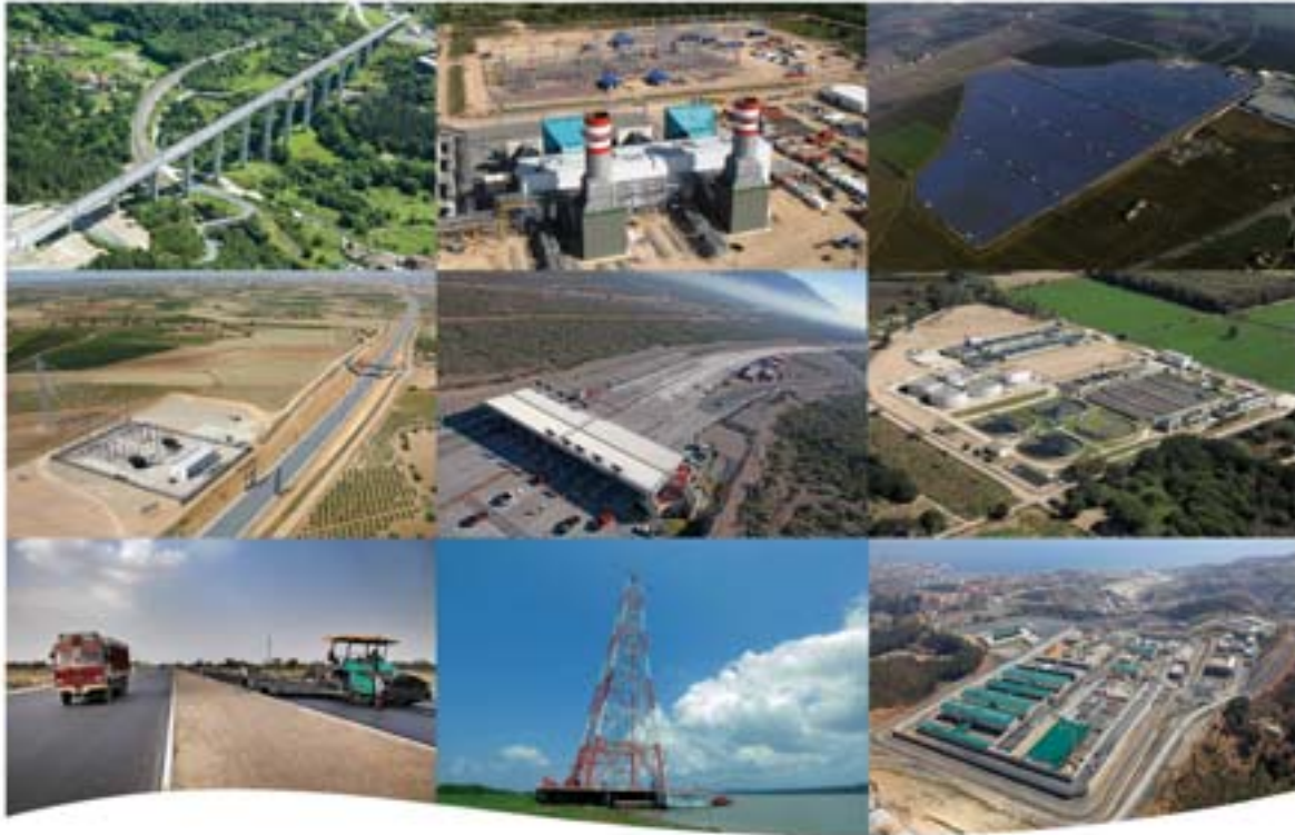
Viaducto AVE Orense - Amoeiro, Orense | España Central de ciclo combinado Ensenada Barragán | Argentina Planta Solar Fotovoltaica, de 72 MW, Rovigo | Italia Sistema de electrificación del AVE Madrid - Levante | España Autopista Saltillo - Monterrey | México EDAR Puerto Vallarta | México Autopista NH8 | India Torre de alta tensión, de 295 m de altura, perteneciente a la línea que cruza el Amazonas | Brasil Centro Penitenciario de Ceuta | España
